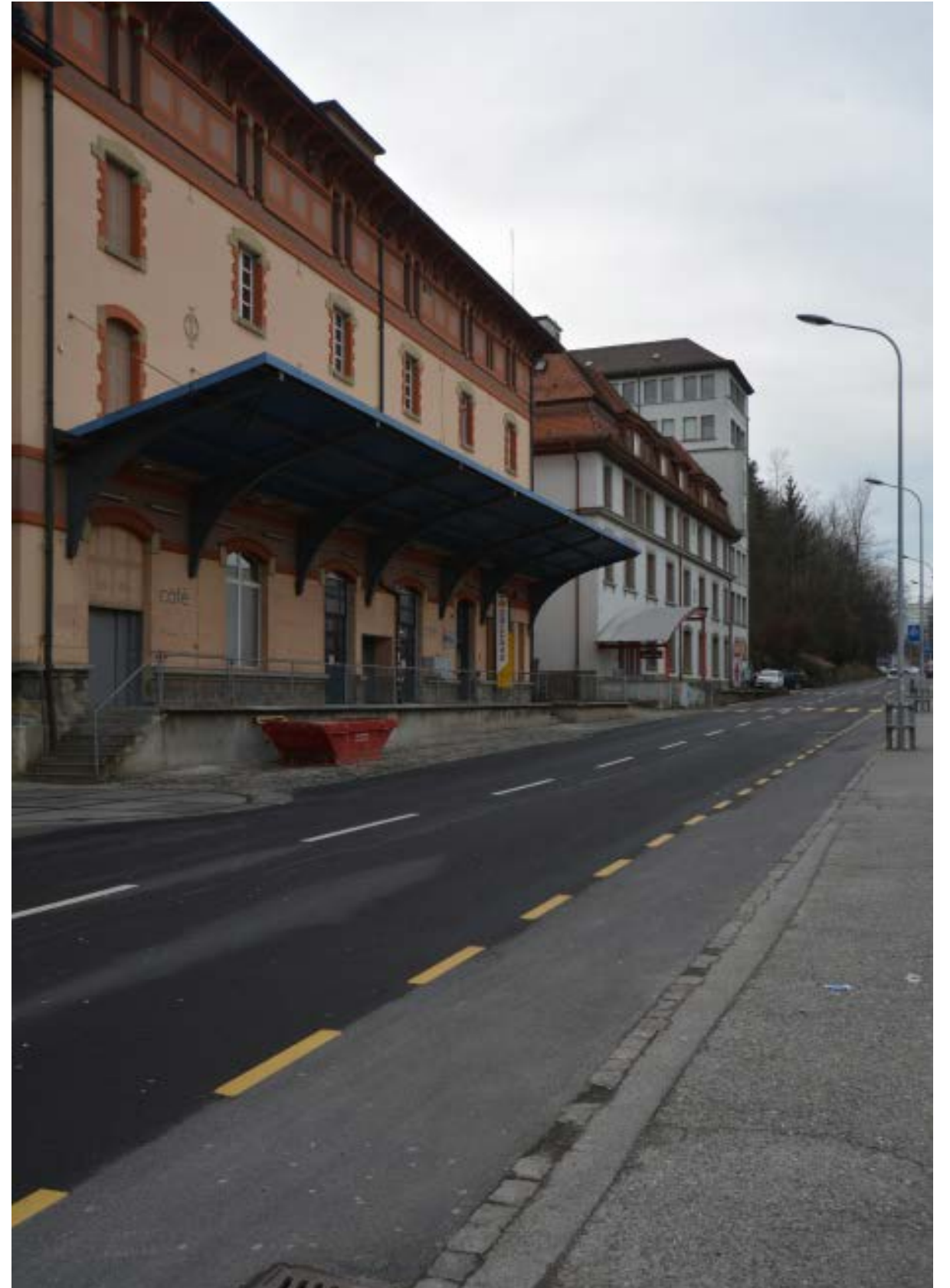
Auf der Südseite der Route de la Fonderie reihen sich die Bauten der früheren Schokoladenfabrik Villars aneinander.
